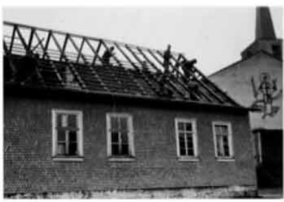
Abb 7: Abriss der alten Schule durch eine Pioniereinheit der Bundeswehr
