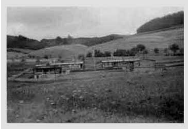
Abb 14: Zwei dahinter querstehende Unterkunftsbaracken, eine Küchenbaracke, vorne links, eine Speiseraumbaracke zwischen Küchen- und Führinnenbaracke, auf dem Bild nicht ersichtlich, wurde später erbaut und diente nach dem Krieg vor allem während der Berlinblockade als Schulgebäude, da die Kapazität der Dorfschule nicht ausreichte.
